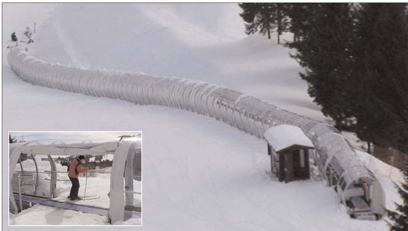
So sehen Innovationen von COMPAC aus: das neue Zubringer-Förderband mit S-Kurve, Kuppel und beidseitigem Seiten-Ausstieg (s. Bild links). Wegen seiner Formgebung wird es in Italien umgangssprachlich auch „la COMPAC banana“ genannt
